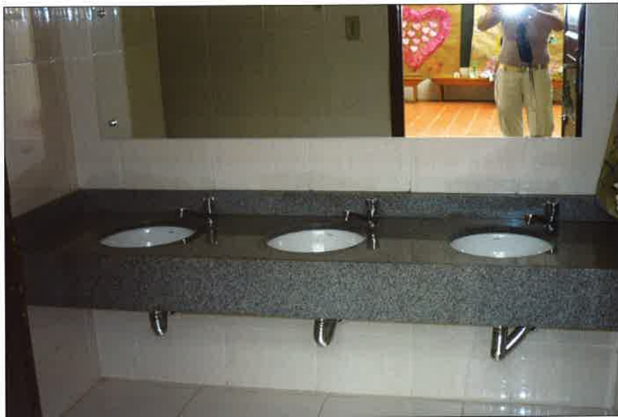
Die sanitären Einrichtungen wurden von Grund auf erneuert.
